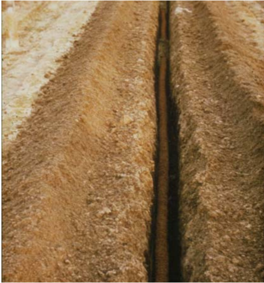
Abb. 3-24: die Dränagerohre müssen mit gleichbleibenden Gefälle verlegt sein
