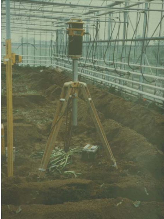
Abb. 3-20: Beispiel für die Verlegung der Dränagerohre in 80 cm Tiefe und Abstand von 2,30 m
