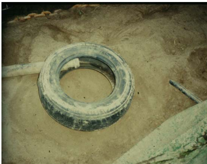
Abb. 7-3: Einfache und zuverlässige Methode, den Dampf unter die Folie zu leiten
