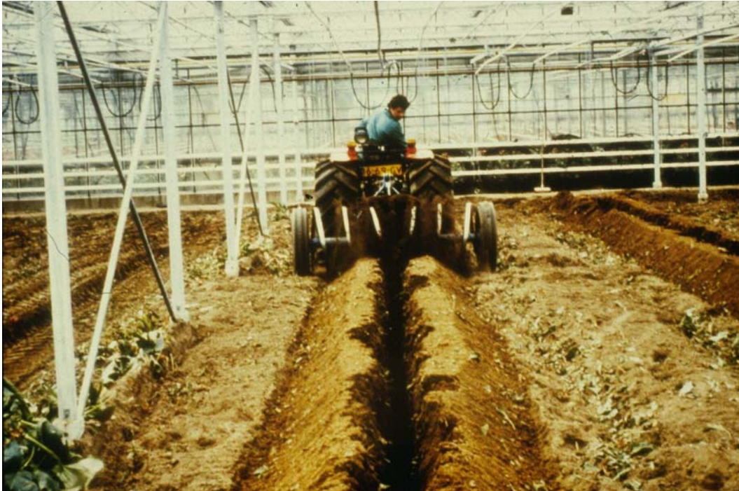
Abb. 3-29: Nach Verlegen der Dränagerohre wird der Boden eingeebnet
