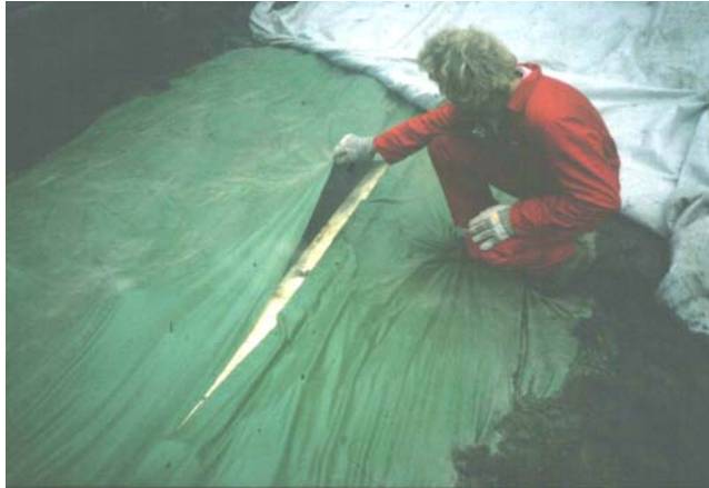
Abb. 7-4: Vorbereitungen zum Reparieren der Folie sind vor dem Dämpfen zu treffen
