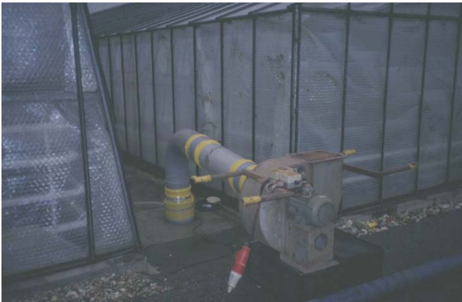
Abb. 3-28: Das Absauggebläse wird in der Regel außerhalb des Gewächshauses installiert
