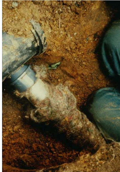
Abb. 3-25: Anschluss der Dränagerohre an den Sammelschacht
