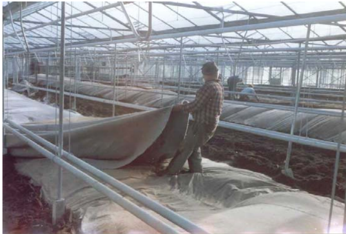
Abb. 7-2: Das Auflegen eines Isoliervlieses ist zwingend erforderlich
