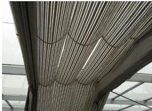
Abb. 1: Schadhafter Energieschirm
